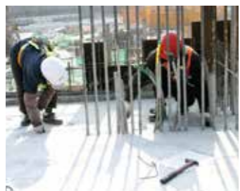
+1 画地面结构线, 确认水平度
