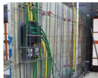
+2 安装电气、管道组件、钢筋。安装内角模板和墙模板。
