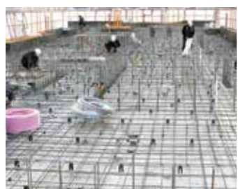
+7 安装电气、管道组件、钢筋。
