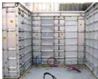
+2 安装电气、管道组件、钢筋。安装内角模板和墙模板。
