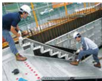
+4 安装楼梯模板
