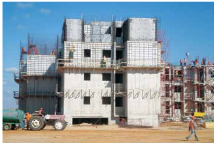
+ 50,000 housing project, 利比亚 的黎波里 - K-Al Form
