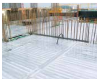
+6 安装顶板模板
