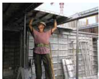
+5 安装顶板模板
