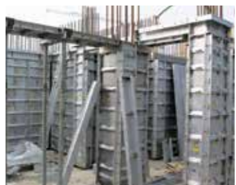
+3 安装梁模和转角模板
