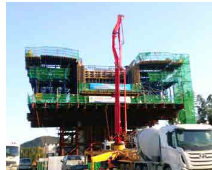
+ 옥동-농소간 1공구 오산대교
