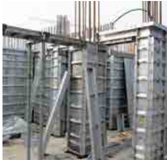
+3 Beam Panel 설치
