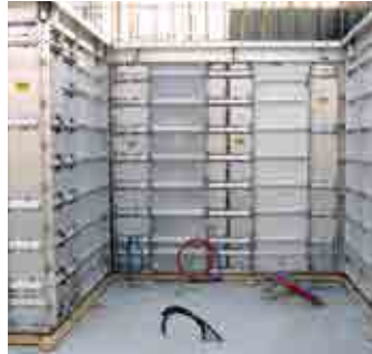
+2 Wall Form 설치
