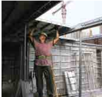
+5 Slab Form 설치
