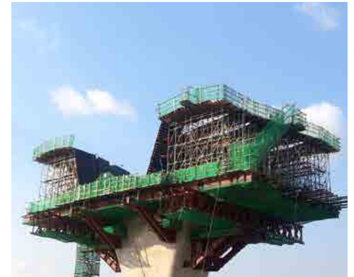
+ 부산 외곽순환도로 8공구 낙동대교
