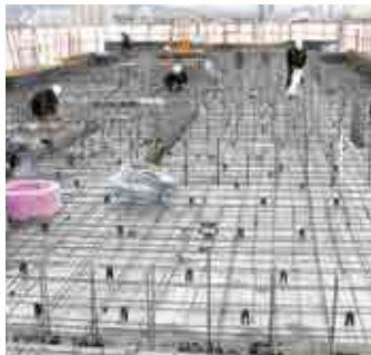
+7 전기 및 설비물 고정과 철근 배근
