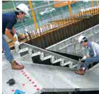
+4 계단 및 Elev-Pit 조립
