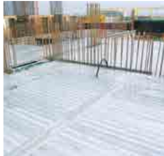
+6 Slab Form 완료 및 단열재 설치
