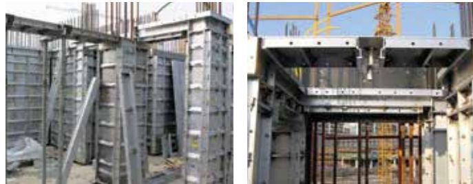
+3 Instalación de viga y paneles SC.
