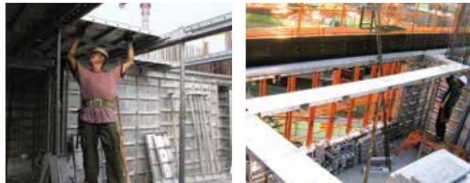
+5 Instalación de paneles de losa.
