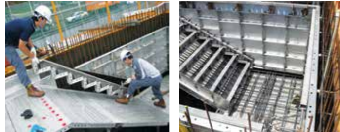
+4 Instalación de paneles de escalera.
