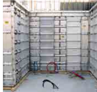
+2 Wall Form 설치
