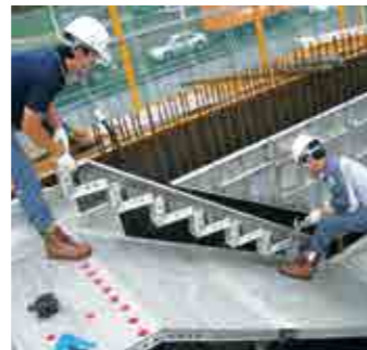
+4 계단 및 Elev-Pit 조립
