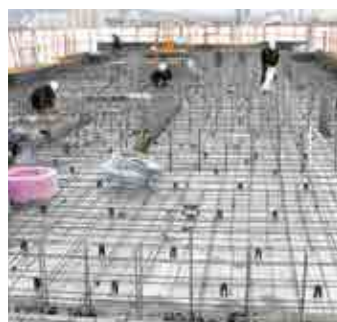
+7 전기 및 설비물 고정과 철근 배근
