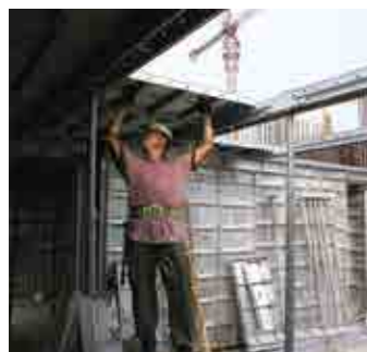
+5 Slab Form 설치
