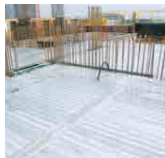
+6 Slab Form 완료 및 단열재 설치
