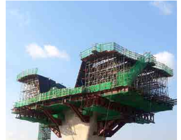
+ 부산 외곽순환도로 8공구 낙동대교
