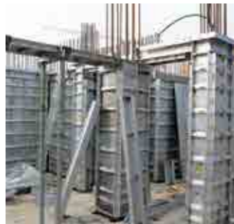
+3 Beam Panel 설치
